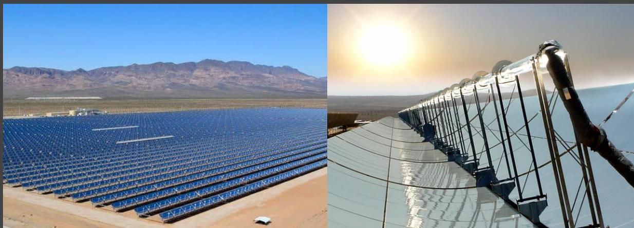
位於內華達的太陽能一號電廠，這是近20年來興建完成的大型商業太陽能電廠之一，被稱為集光型太陽能發電或所謂「CSP」。這些鏡子將比一般强度高70倍的陽光，聚焦在一根裝了合成油，被稱做集熱管的長圓柱，直到溫度達到接近攝氏4百度，接著滾燙管子經過熱傳導器，將水變成蒸氣，最後用蒸氣驅動渦輪，來產生電力。
