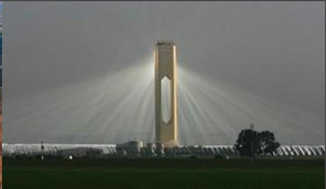
位於西班牙西南部陽光充足的地區，624片巨大反光鏡聚光，每片反光鏡能隨太陽移動而作角度調整，將太陽光聚集於115公尺的高塔上，塔上設有陽光收集器和蒸汽輪機，當陽光聚集時能產生攝氏250度以上的高溫，可將塔內的液體蒸發，產生蒸氣，再傳送至塔底，推動渦輪機來發電，可提供約5500戶的家庭用電，每年可減少18000噸的二氧化碳排放量，但目前的的困難是發電成本高於傳統發電3倍。
