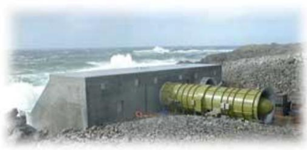
振盪水柱式 波浪發電機
